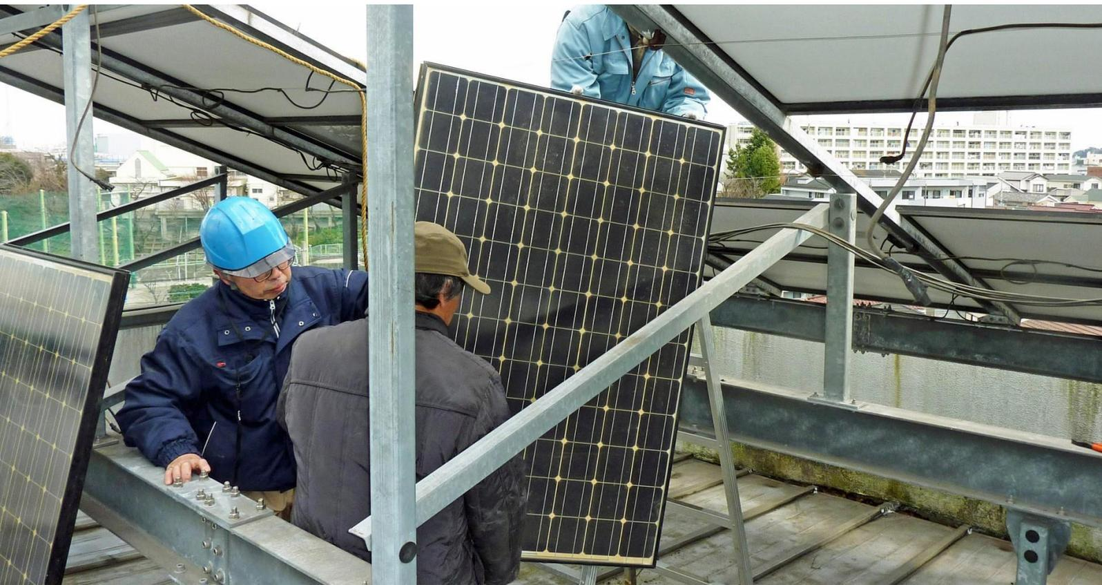
バイパスダイオード故障が確認された PV システムのパネル取り外し作業
